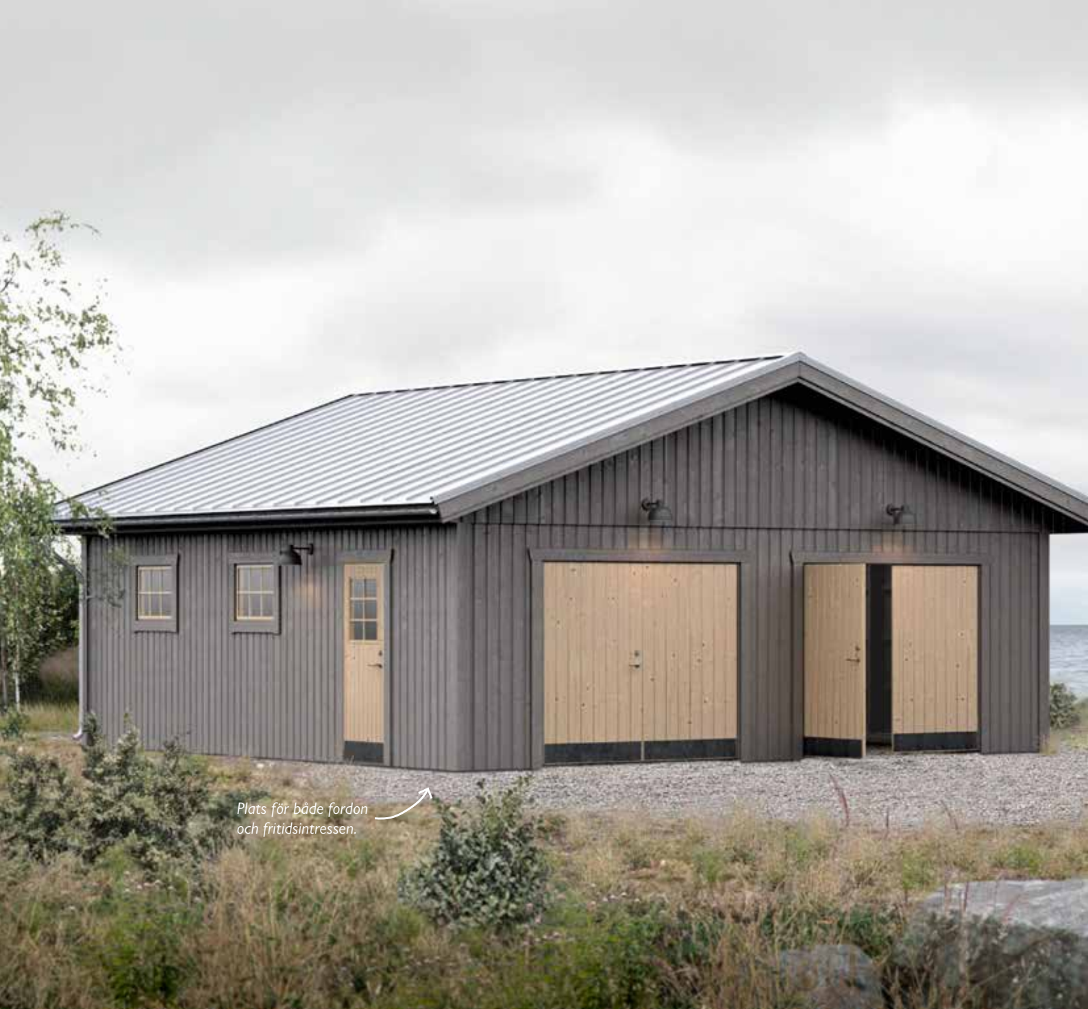
Bilden visar dubbelgaraget Gavas och attefallshuset Risnäs
